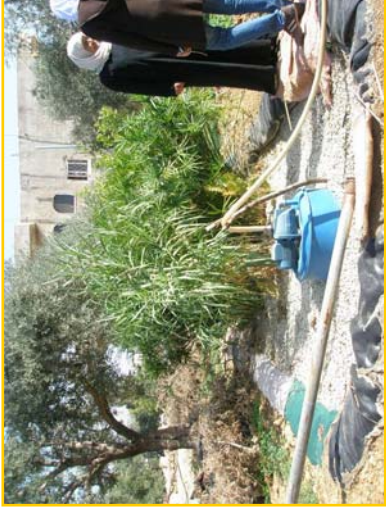
أرض رطبة اصطناعية في حديقة منزلية في الأردن.
